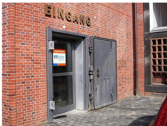
22. ábra: Vízárást biztosító nyílászárók
