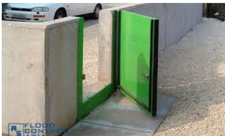
24. ábra: Épülethez tartozó terület egyedi árvízvédelme
