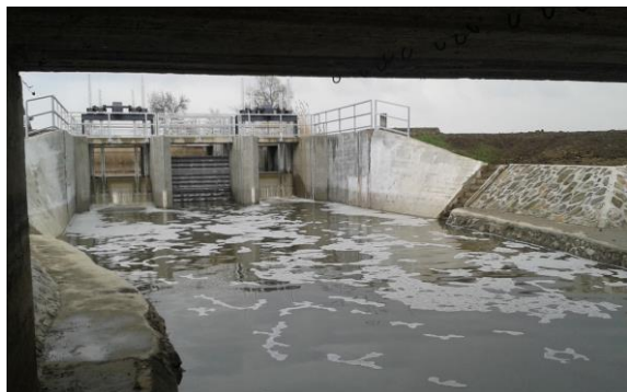
1 ábra: Vízszintszabályozó műtárgy a Kurca-főcsatornán
