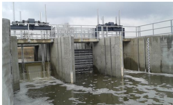
1 ábra: Vízszintszabályozó műtárgy a Kurca-főcsatornán
