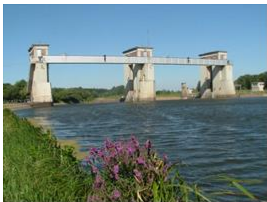
2-1. ábra: A békésszentandrás vízlépcső
